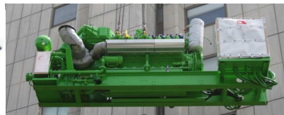
Grupo motogenerador 1 MWe
